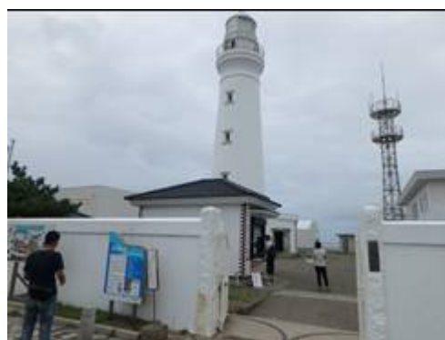
1874年初灯。31.2m。日本に5つしかない最大の第1等レンズを使用した第1等灯台。
